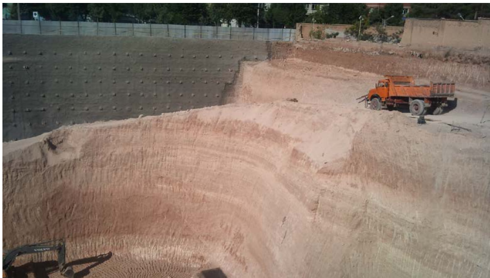
شکل ۲- نمایی از ضلع جنوبی پروژه برج‌های دو قلو شهر کرد
